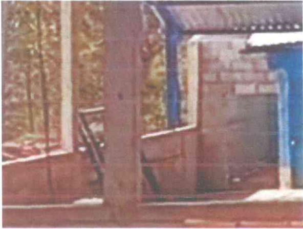
Foto1: Muro Perimetral, solo falta poner la malla, en un 96%.
